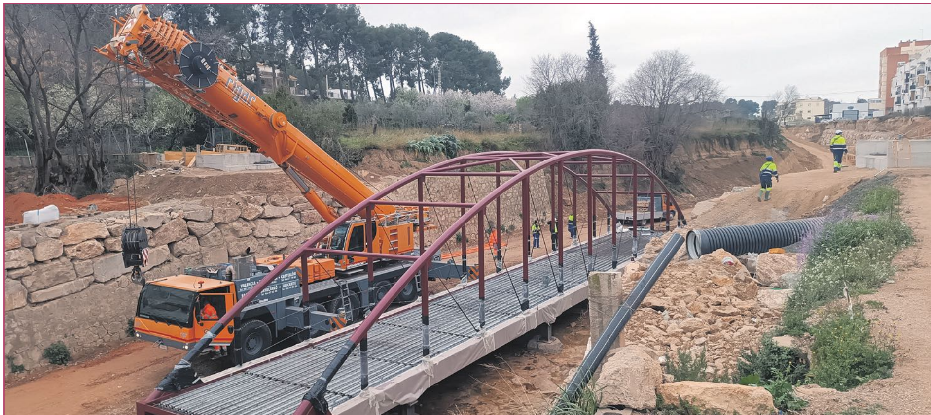
Reparaciones en Chiva de infraestructuras destruidas por la dana.
