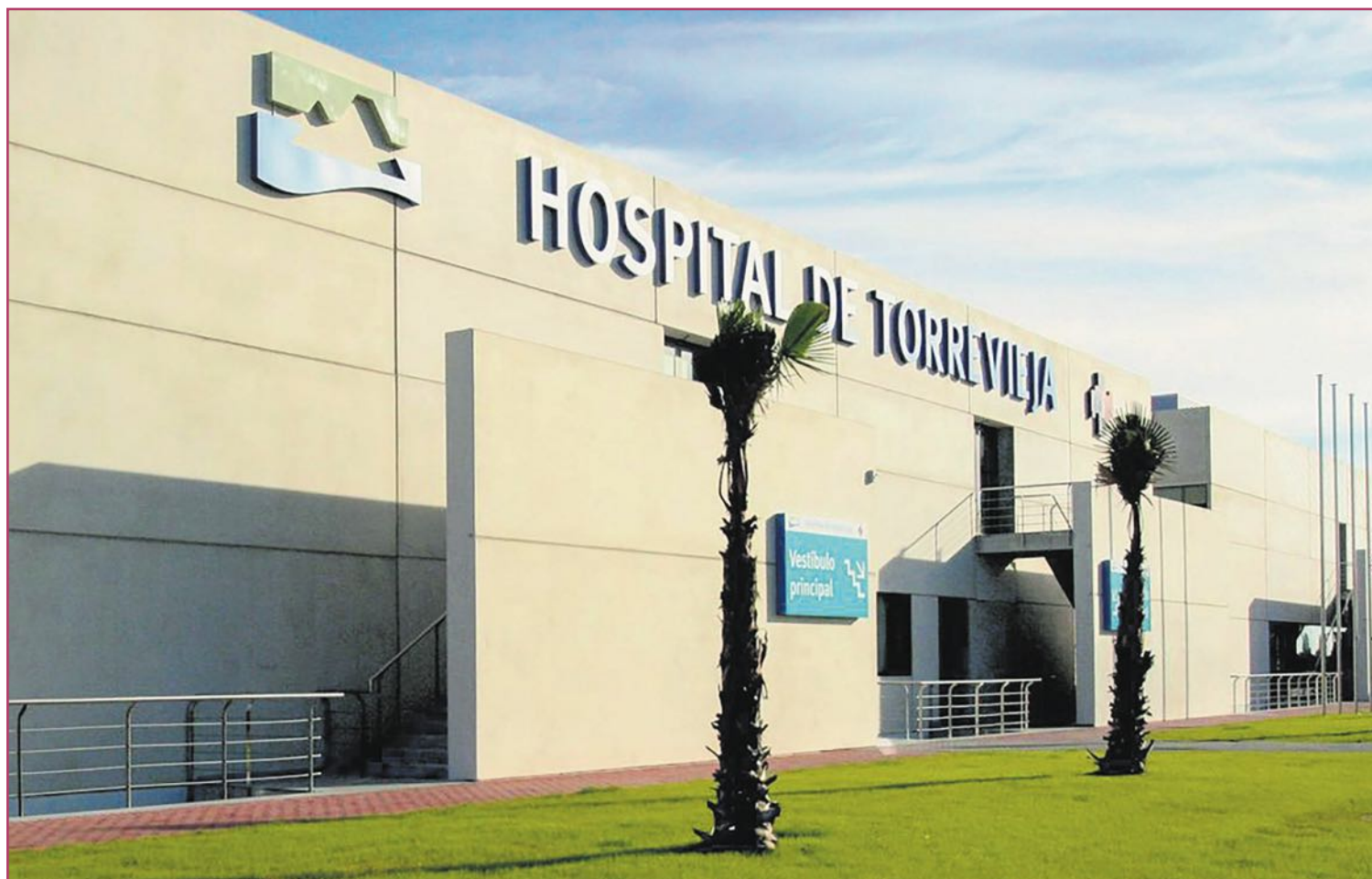
El Hospital de Torreveija tendrá una ambiciosa ampliación sin interferir en el día a día del trabajo sanitario.
